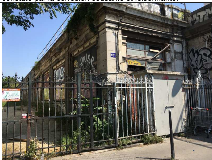
Photo 12 : Culée côté quai 2 - Présence de végétation localisée due à un manque d'entretien.
