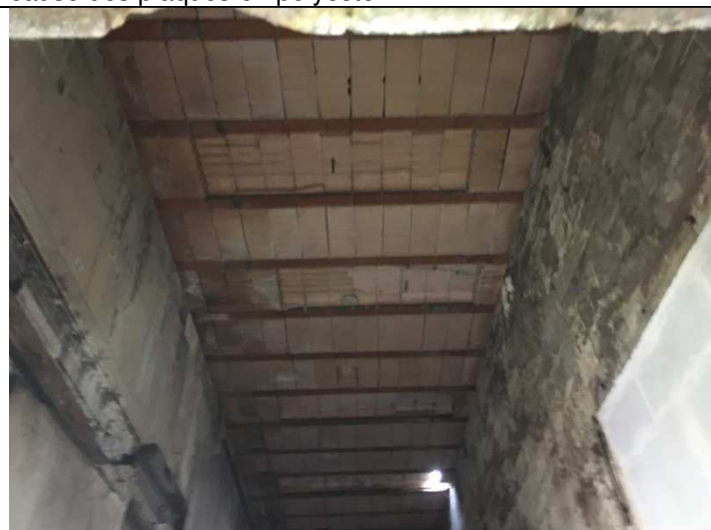
Photo 6 : Intrados quai n°2 côté extrémité – Il est constaté une oxydation de surface des poutrelles ainsi que plusieurs hourdis dégradés en intrados (seule partie visible).
