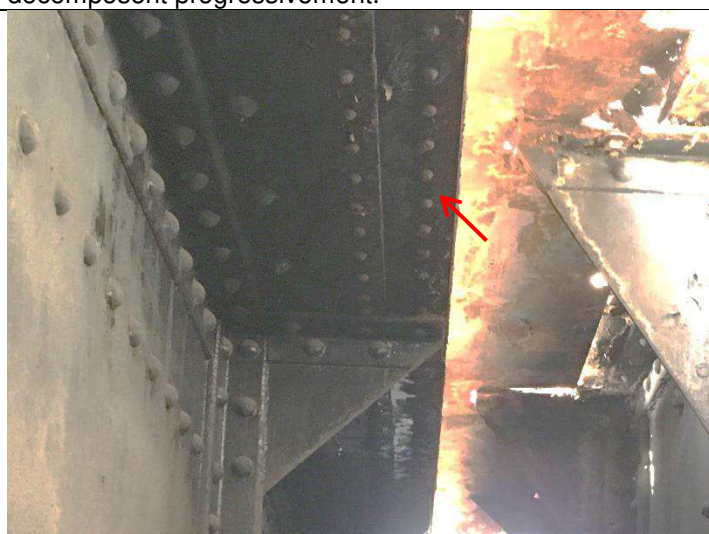
Photo 4 : Poutres principales – Réduction de section des semelles supérieures (et inférieures) des poutres d'extrémités. La réduction de section de l'ordre de 25% est antérieure à la dernière réfection de la protection anticorrosion. Sur environ 70% des nœuds
