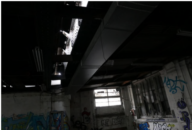
Jour visible à travers les panneaux métalliques percés par la corrosion
