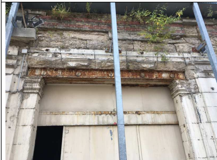
Photo 15 : Façades 1 et 2 – Les pilastres ainsi que les parements se dégradent due au manque d'entretien.
