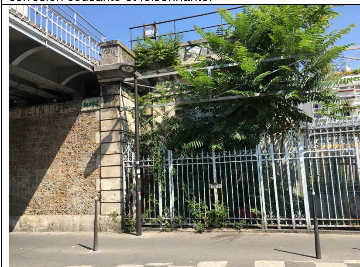
Photo 11 : Culée côté quai 2 - Présence de végétation localisée due à un manque d'entretien.
