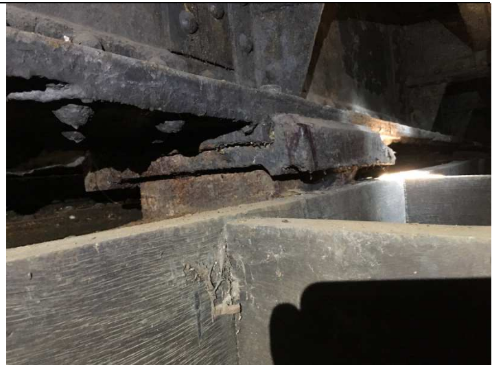
Photo 8 : Appareil d'appuis sous poutre principale gauche, sur pile – Cassure de la platine supérieure de l'appui.
