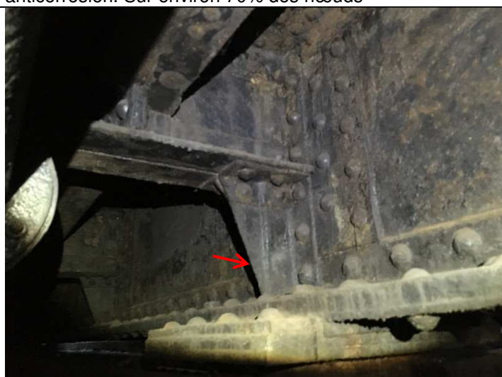
Photo 6 : Jonction PP/PdP – Réduction en lame de couteau du gousset vertical de la chaise d'appui des PdP.
