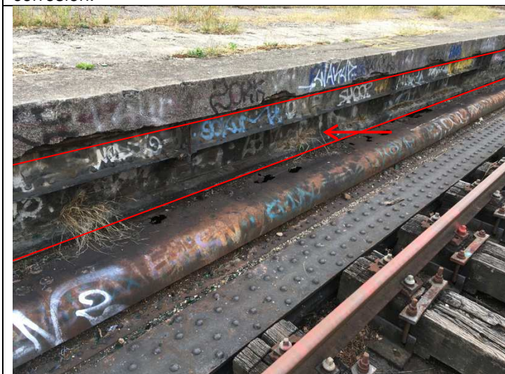
Photo 9 : Peinture poutre droit quai 1 (partie supérieur des poutres visible depuis l'extrados) – Dégradation importante de la protection anticorrosion constaté par la corrosion ceusante et foisonnante.
