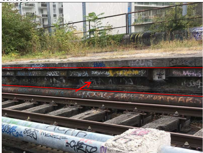
Photo 10 : Peinture poutre gauche quai 2 (partie supérieur des poutres visible depuis l'extrados) – Dégradation importante de la protection anticorrosion constaté par la corrosion ceusante et foisonnante.
