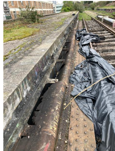
Photo n° 4 : Platelage perforé le long du quai
