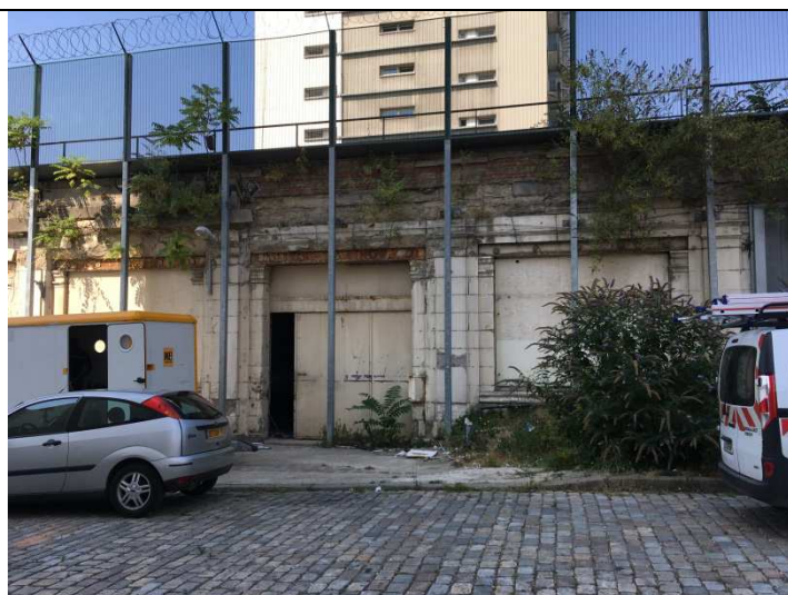
Photo 14 : Façade quai 2 – Les bardages ont été retirés pour la mise en place d'un grillage anti-jet de pierres. La végétation gagne du terrain au droit du couronnement.
