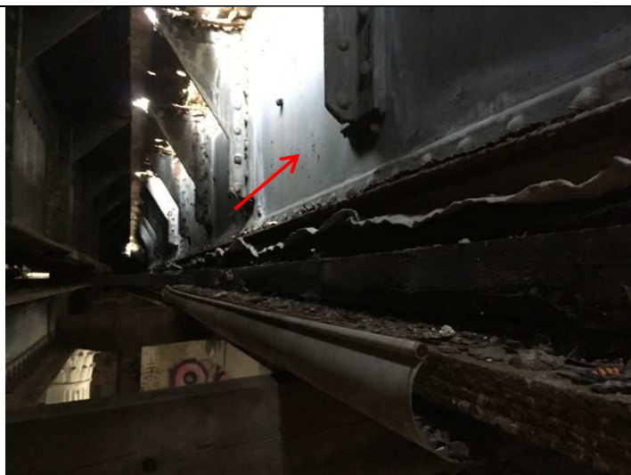
Photo 8 : Peinture poutre gauche quai 2 (partie inférieur des poutres visible depuis l'intrados) – La protection anticorrosion s'écaille progressivement et laisse place à la corrosion.
