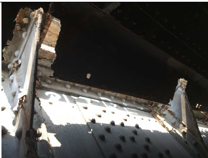
Photo 11 : Perforation de la tôle entre les tabliers de quais et le tablier du pont-rail. Cette tôle n'assure plus son rôle de protection contre les intempéries.
