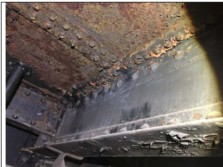
Photo 13 : Peinture (généralisé sur l'ouvrage) – Dégradation progressive de la protection anticorrosion, jusqu'à complète disparition dans les zones confinées ou soumises à l'humidité.
