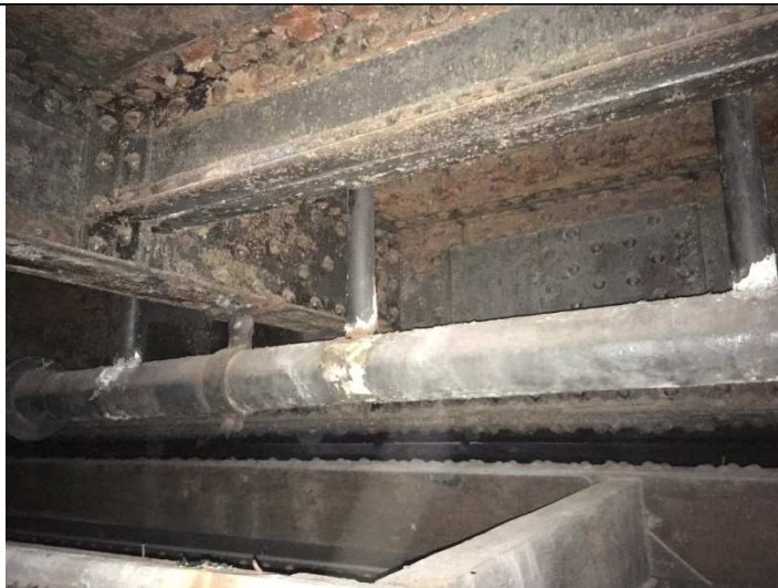
Photo 7 : Déconsolidation sur environ 30% des longerons, des cornières membrures supérieures des longerons, notamment sous TMV1 (rivure des cornières membrures inférieures).
