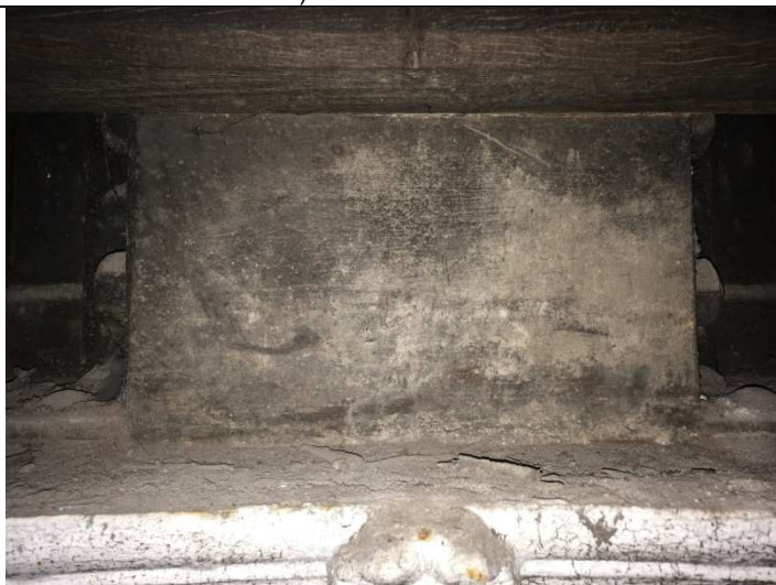
Photo 9 : Appareil d'appuis sous poutre principale gauche, sur pile – partie inférieure.
