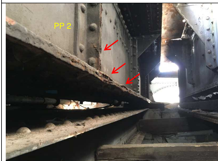
Photo 5 : Extérieur des poutres principales – Festonnage entre les cornières montantes. Désordre causé par l'absence de fourrure. Corrosion creusante des cornières montante.
