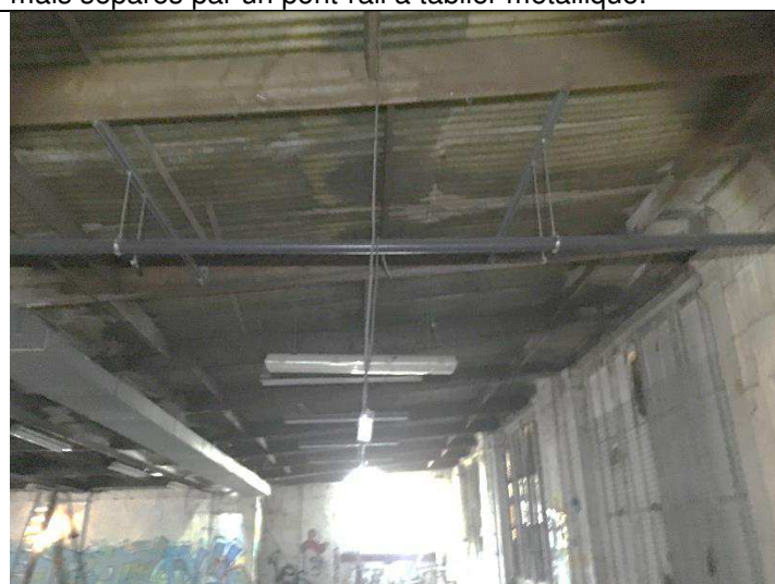
Photo 4 : Intrados du quai 1 - Intrados non visible à cause des plaques en polyester.
