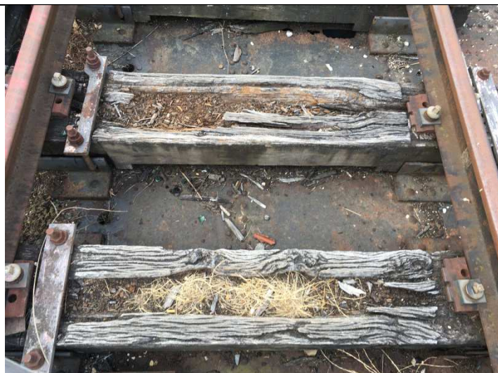
Photo 2 : Voies V1 et V2 – Les travers bois se décomposent progressivement.
