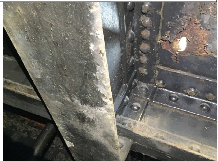
Photo 10 : Perforation du platelage. La zone se situe sous une traverse bois. Plusieurs zones de réparation par plat soudé sont relevées sur le platelage.
