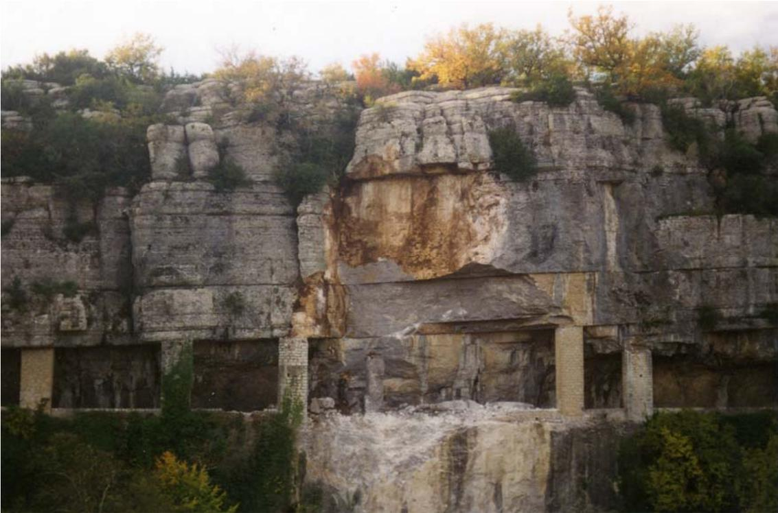
Illustration 33 - Exemple de chutes de blocs à LABEAUME (1981) - RD4 - N° 60700779 - Calcaires - Jurassique supérieur
