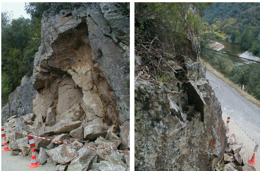
*Illustration 30 (Source BRGM) - Exemple de chutes de blocs à BEAUMONT (10/2001) - RD220 - N° 60700726 - Schistes*
