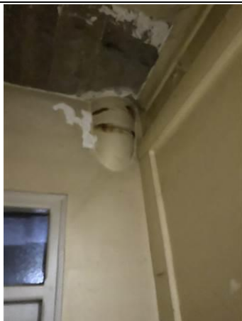
Photo n° PhA005 Localisation : 2ème étage - Dgt Ouvrage : 6 - Conduits et accessoires intérieurs - Conduits de fluides (air, eau, vapeur, fumée, échappement, autres fluides) Partie d'ouvrage : Conduit en fibres-ciment Description : Conduit en fibres-ciment
