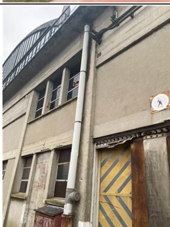
Photo n° PhA006 Localisation : Extérieur - Façade Ouvrage : 6 - Conduits et accessoires intérieurs - Conduits de fluides (air, eau, vapeur, fumée, échappement, autres fluides) Partie d'ouvrage : Conduit en fibres-ciment Description : Conduit en fibres-ciment
