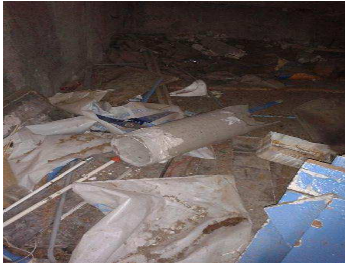
Local 02 (01) - Conduit de fumées - Sol - Présence d'amiante
