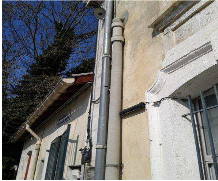
Façade Sud (00) - Façade –Conduit de fluide en amiante- Présence d'amiante
