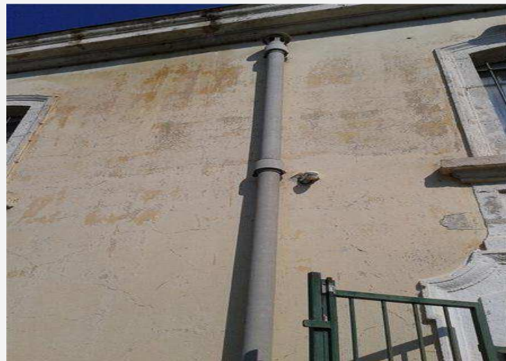
Façade Sud (00) - Façade - Conduit de fluide en amiante- Présence d'amiante
