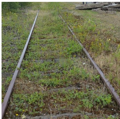
Plancher de la Voie B
