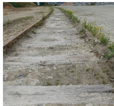
Tronçon bois en état acceptable
