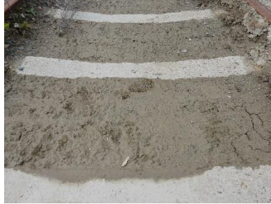
Traverses en béton dans la glaise
