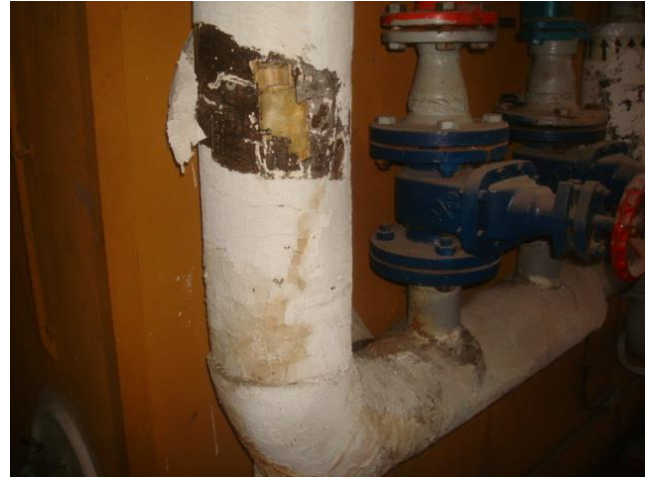
Composant : Joints de chaudière et de conduit 17 (a)
