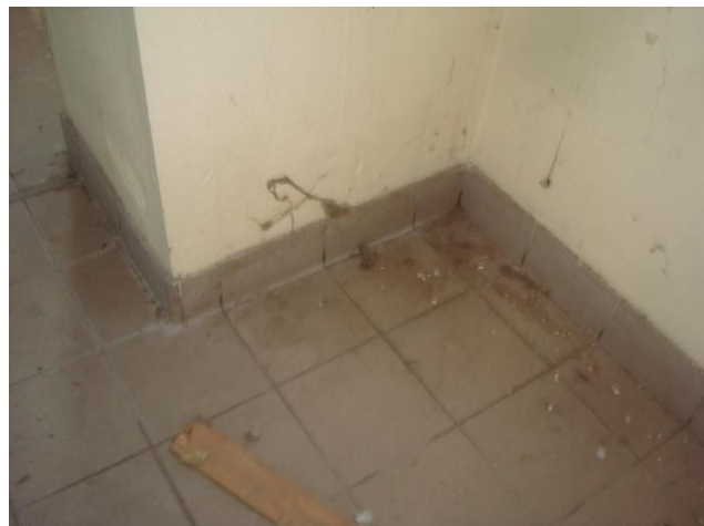
Composant : Colles des carrelages 5 (N) sous plinthes niveau
