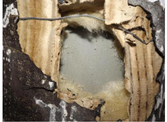
Composant : Calorifugeage 27 (N) sur conduits réseau
