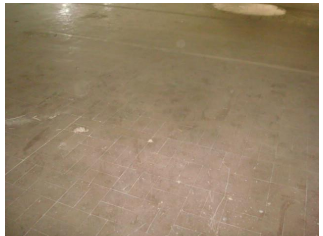
Composant : Ragréage 11 (N) sous dalle béton niveau 1
