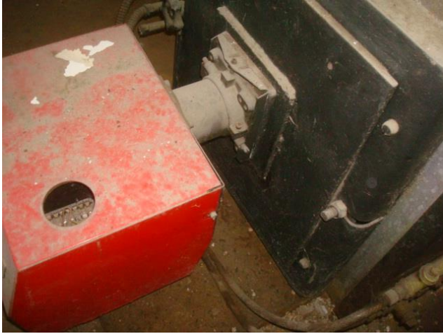
Composant : Calorifugeage 18 (N) laine de verre et carton noir conduits chaufferie
