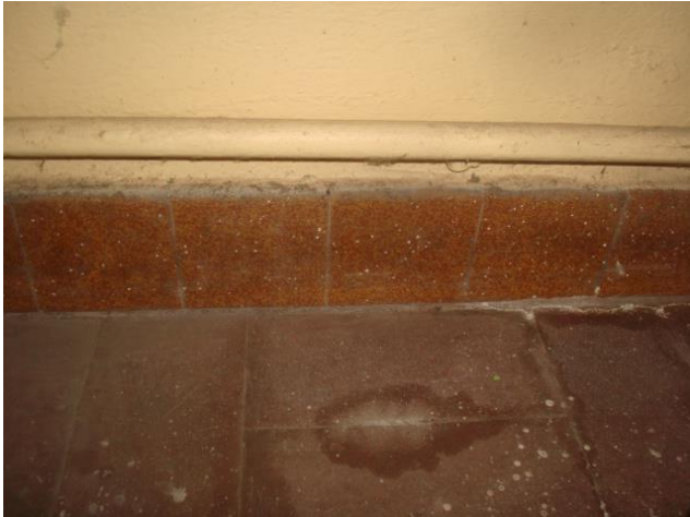
Composant : Colles des carrelages 10 (N) sous plinthes niveau 1
