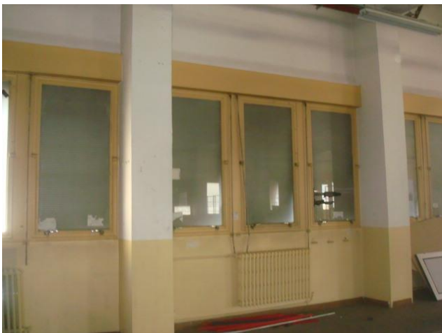
Composant : Joint de vitrage / menuiserie 12 (N) mastic vitrier fenêtres du niveau
