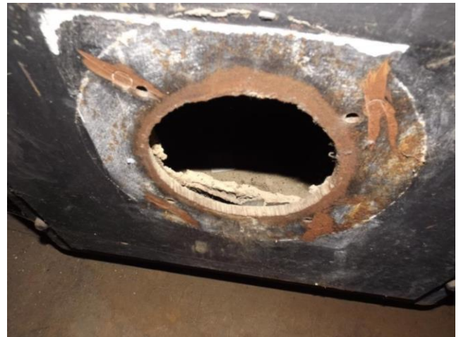
Composant : Joints de chaudière et de conduit 25 (N)
