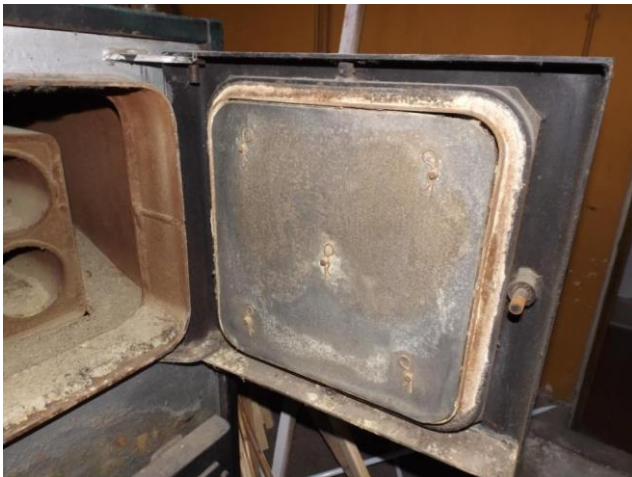
Composant : Joints de chaudière et de conduit 24 (a)
