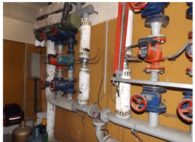
Composant : Enveloppe de calorifugeage 26 (N)
