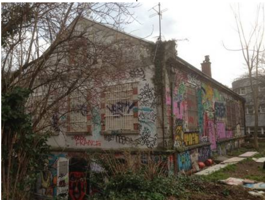
Vue côté voies petite ceinture
