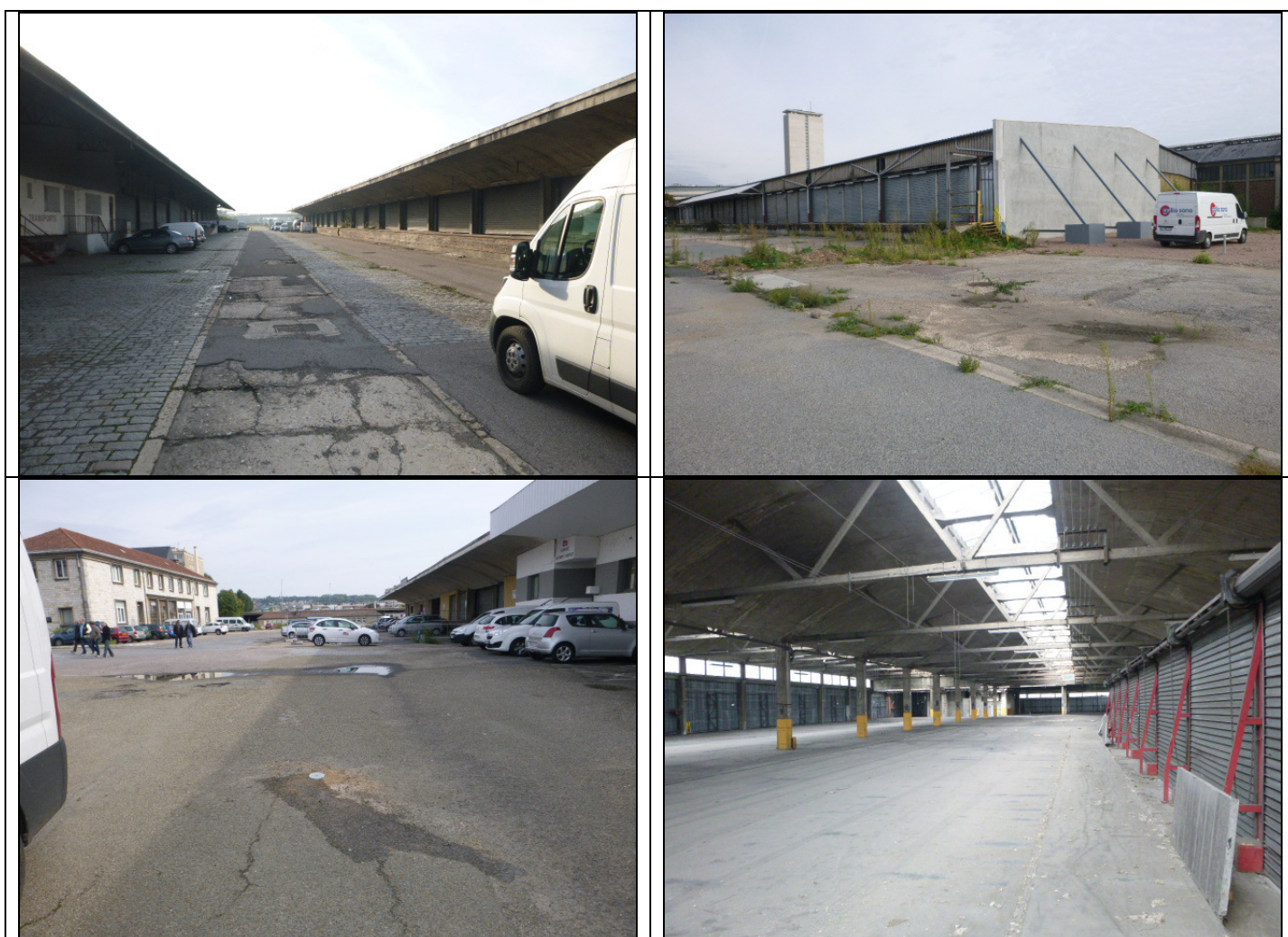
Figure n°8 : Photographies de la configuration actuelle du site.
