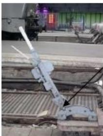
A la fin de chaque manœuvre de l'appareil de voie, l'agent de l'entreprise ferroviaire doit vérifier que le verrou du levier de type "I" à crans soit bien retombé dans le cran correspondant
