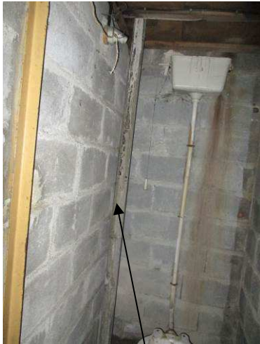
IV : BAT 382/A14 - RDC - WC - Conduit - Photo n° 19
