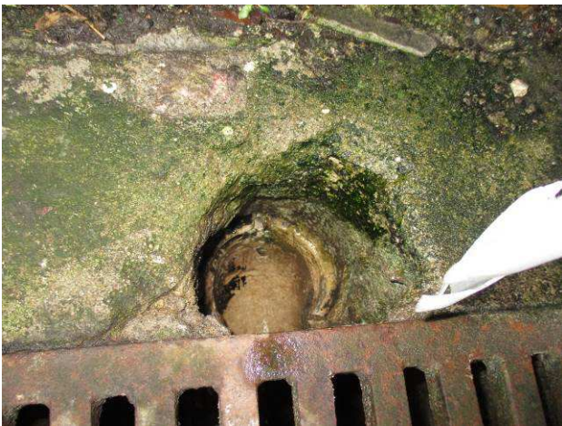
IV : BAT 382/A8 - RDC - Façades - Conduit en amiante ciment : eaux pluviales - Photo n° 3
