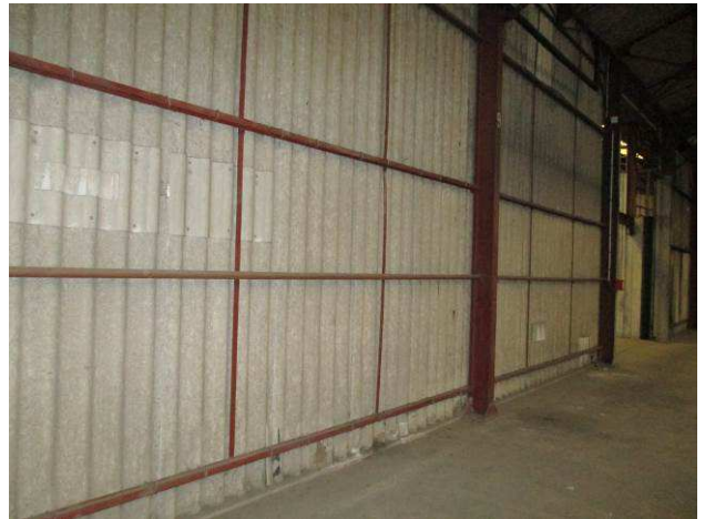
IV : BAT 382/A12 - RDC - Local 006 hall - Revêtement dur (plaques amiante-ciment) - Photo n° 14
