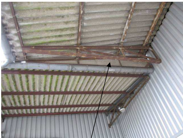
IV : BAT 382/A12 Auvent toiture - Plaque - Photo n° 7
