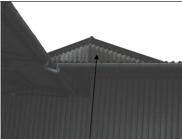
IV : BAT 382/A8 - RDC - Façades - Conduit en amiante ciment : eaux pluviales - Photo n° 3
