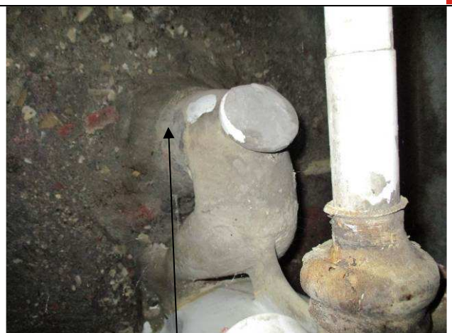
IV : BAT 382/A14 - RDC - Façades - Conduit en amiante ciment : eaux pluviales - Photo n° 16
