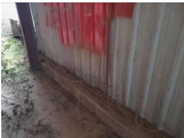
Peinture à la bombe sur le bardage et déformations
