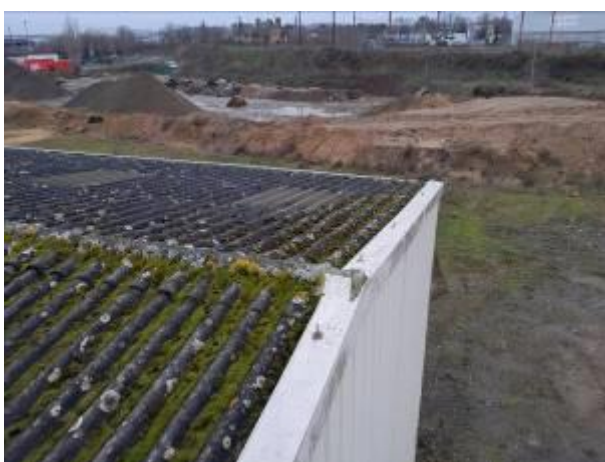
Photos des désordres type en surface de toiture –développement de mousse généralisé
