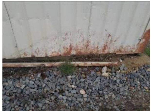
Désolidarisation bavette de bardage
