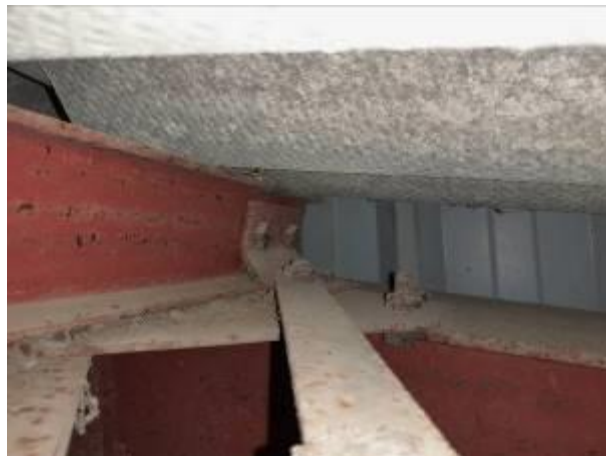
Photos des désordres type en sous face de toiture – corrosion des organes d'assemblages, piqure de rouille et altération de la peinture
