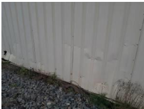
Déformations des plaques de tôle nervurées du bardage – vue extérieure
