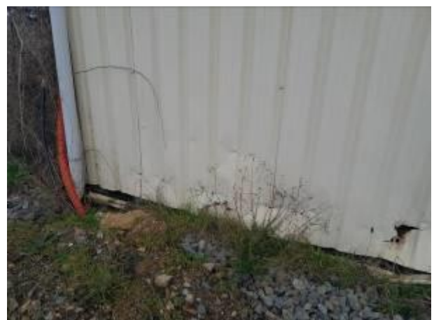
Désolidarisation bavette de bardage
