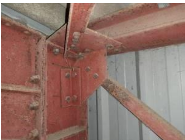
Photos des désordres type en sous face de toiture – corrosion des organes d'assemblages, piqure de rouille et écaillage de la peinture
