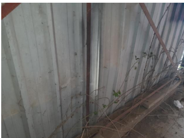
Entrebâillement et ouverture de la tôle, développement de végétation en partie basse
