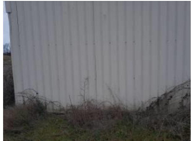
Entrebâillement tôle et végétation
