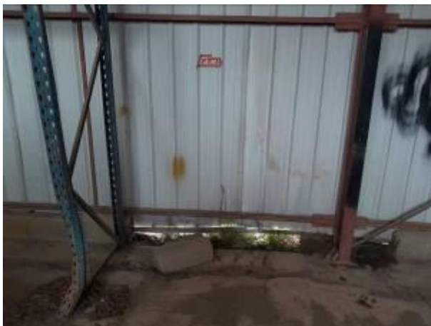
Peinture à la bombe sur le bardage et altérations des blocs agglos en pied de bardage
