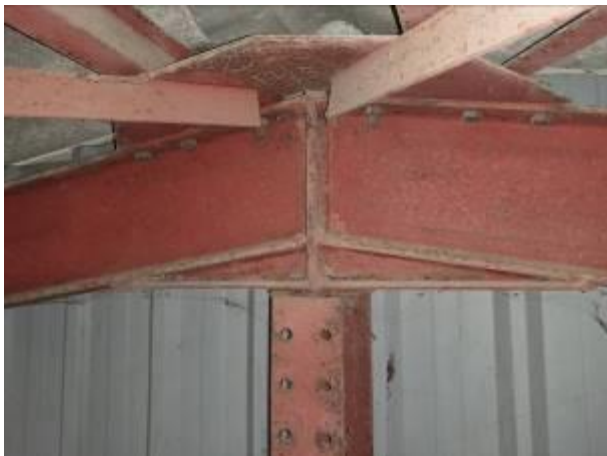
Photos des désordres type en sous face de toiture – corrosion des organes d'assemblages, piqure de rouille et altération de la peinture
