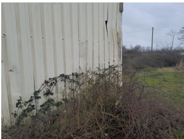
Déformations des plaques de tôle nervurées du bardage – vue extérieure
