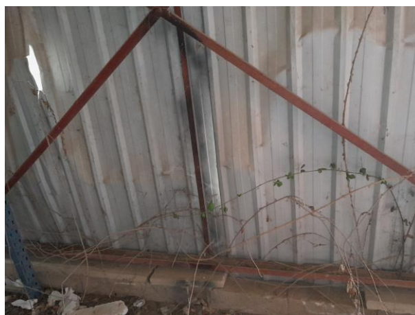
Entrebâillement et ouverture de la tôle, développement de végétation en partie basse
