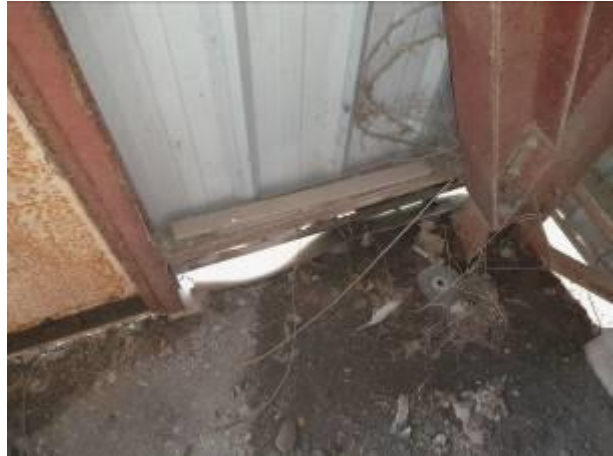
Trace d'humidité dans un angle
