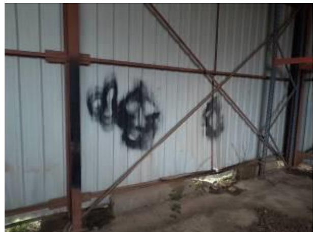
Peinture à la bombe sur le bardage et altérations des blocs agglos en pied de bardage
