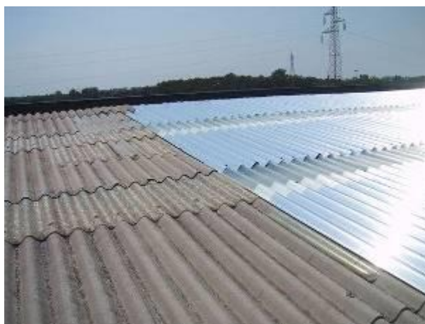
Exemple de sur-couverture simple peau bac acier sur plaque ondulées
