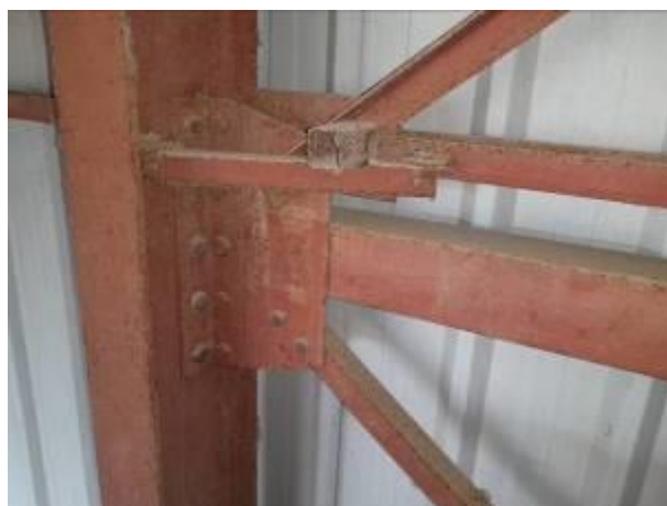
Photos des désordres type en sous face de toiture – corrosion des organes d'assemblages, piqure de rouille et écaillage de la peinture
