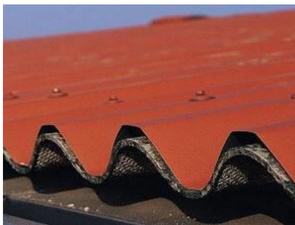
Exemple de sur-couverture simple peau bac acier sur plaque ondulées
