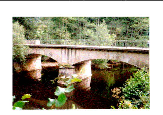
Pont de la RD944/RD10
