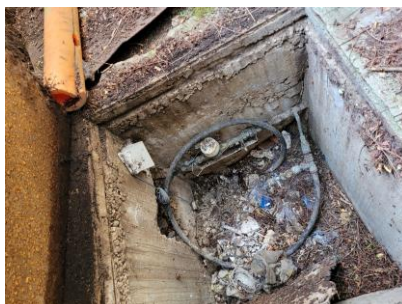
intérieur du regard
