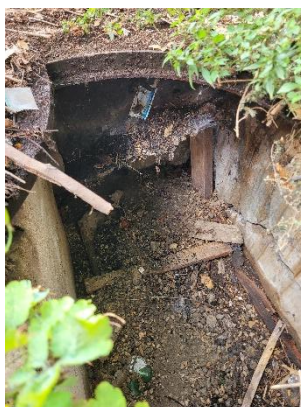
intérieur du regard
