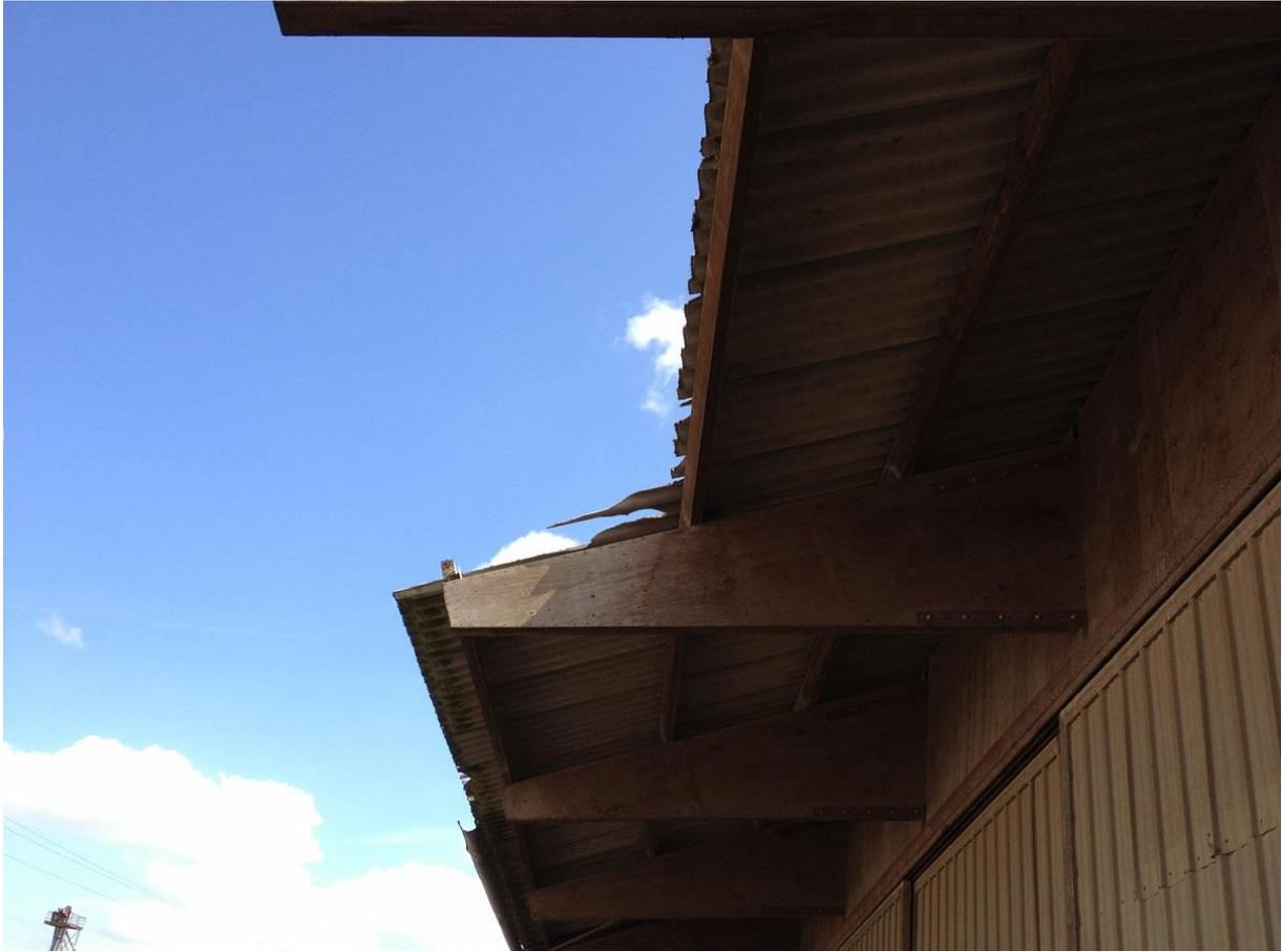
**MCA 002 : Plaques ondulées de couverture en fibre-ciment**
