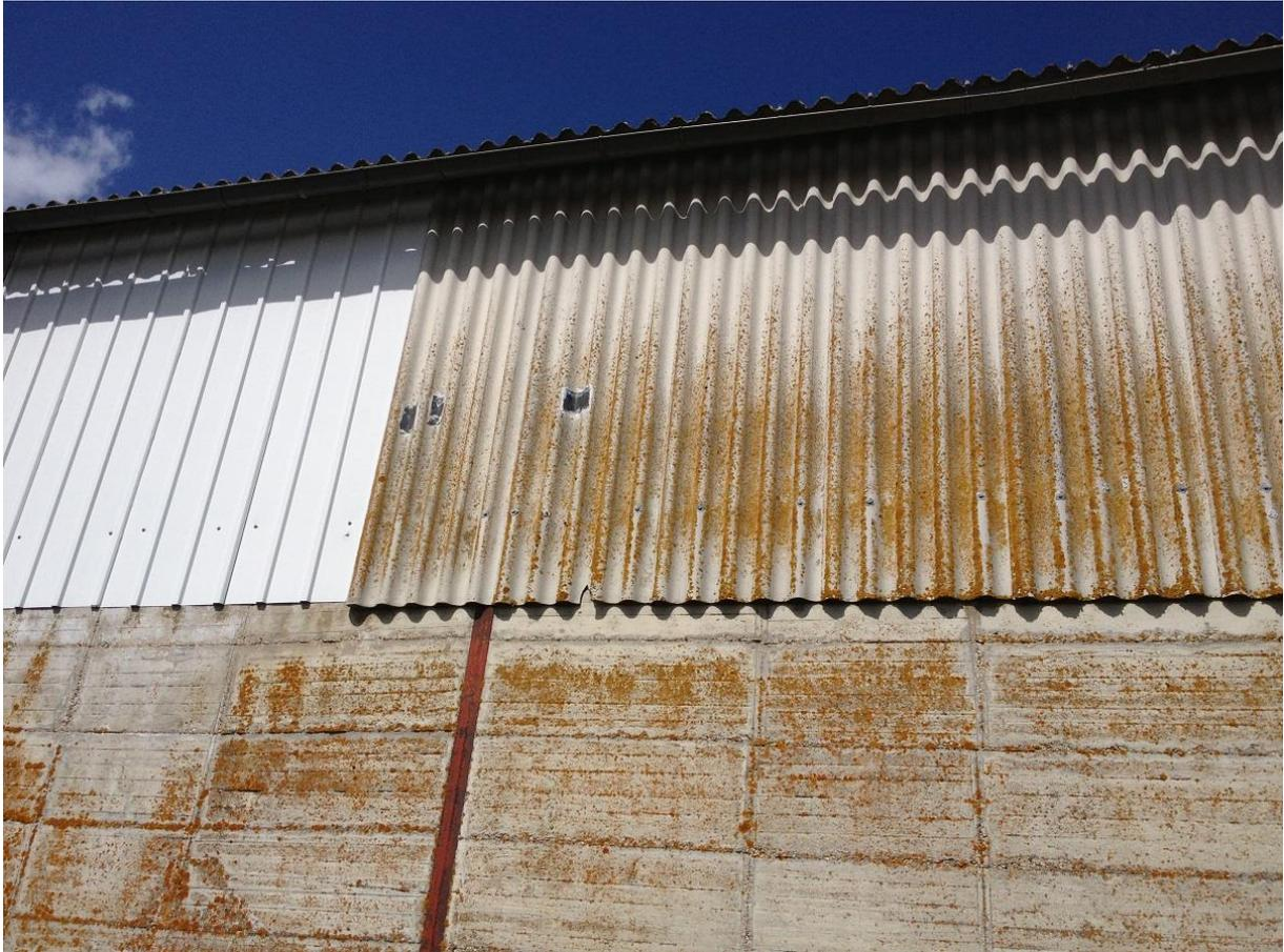
**MCA 003 : Plaques ondulées de bardage en fibre-ciment**
