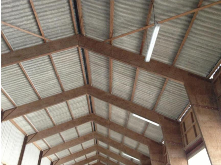
**MCA 001 : Plaques ondulées de couverture en fibre-ciment**
