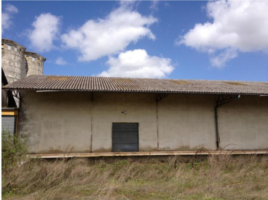
**MCA 003 : Plaques ondulées de couverture en Fibre-ciment**
